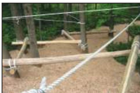
Pour maximiser la prise de la main sur la corde, le diamètre moyen de la corde de sécurité doit être de 12 mm (1/2 po). La hauteur de la corde de sécurité varie en fonction de la taille des participants, de l'exercice à réaliser et du type de module.
