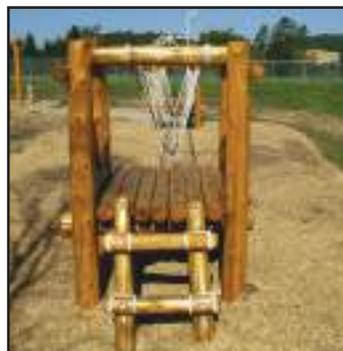
La barrière de protection peut être une simple corde, mais d'un diamètre beaucoup plus gros que celui d'une corde de sécurité. Il est recommandé d'opter pour une corde de 2,5 à 5 cm (1 à 2 po). La corde doit être fixée solidement entre deux points et suffisamment tendue pour stabiliser le participant en cas de perte d'équilibre. Une corde desserrée risque de provoquer une chute ou un emmêlement.
